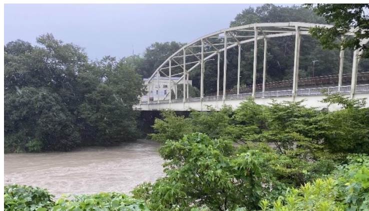
天龍峡姑射橋上流側
